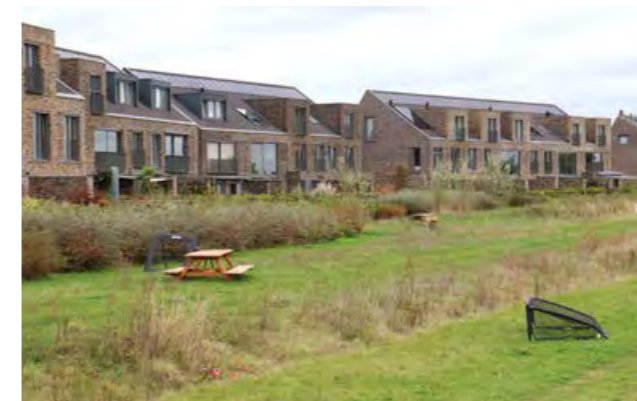
Rijwoningen aan het groen met geïntegreerde overgangszone en gewenste variatie en plasticiteit
