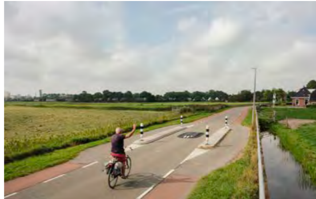
Smalle sloten langs de Leegeweg in bestaande situatie
