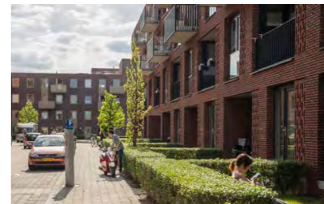
Verdiepte buitenruimtes op de begane grond en eerste verdieping met daarboven halfverdiepte balkons
