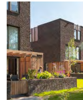
Gebouwd terras aan groen
