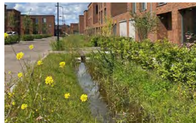
Regenwater wordt zichtbaar opgevangen en afgevoerd in de openbare ruimte
